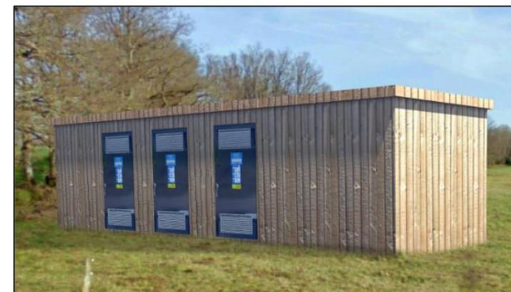
Photographie 4 : Exemple d'un local technique équipé de bardage bois (source : ENCIS Environnement)
