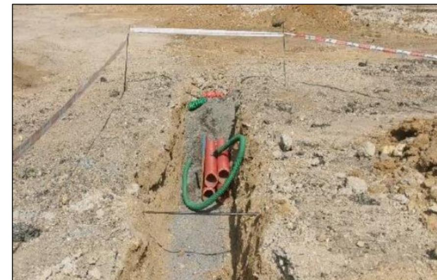
Photographie 7 : Exemple de fourreaux en tranchée (source : SOG Solar)
