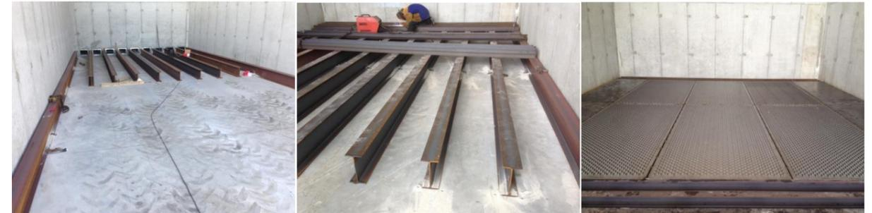
Figure 17: Pose de la structure IP sous les tôles perforées
